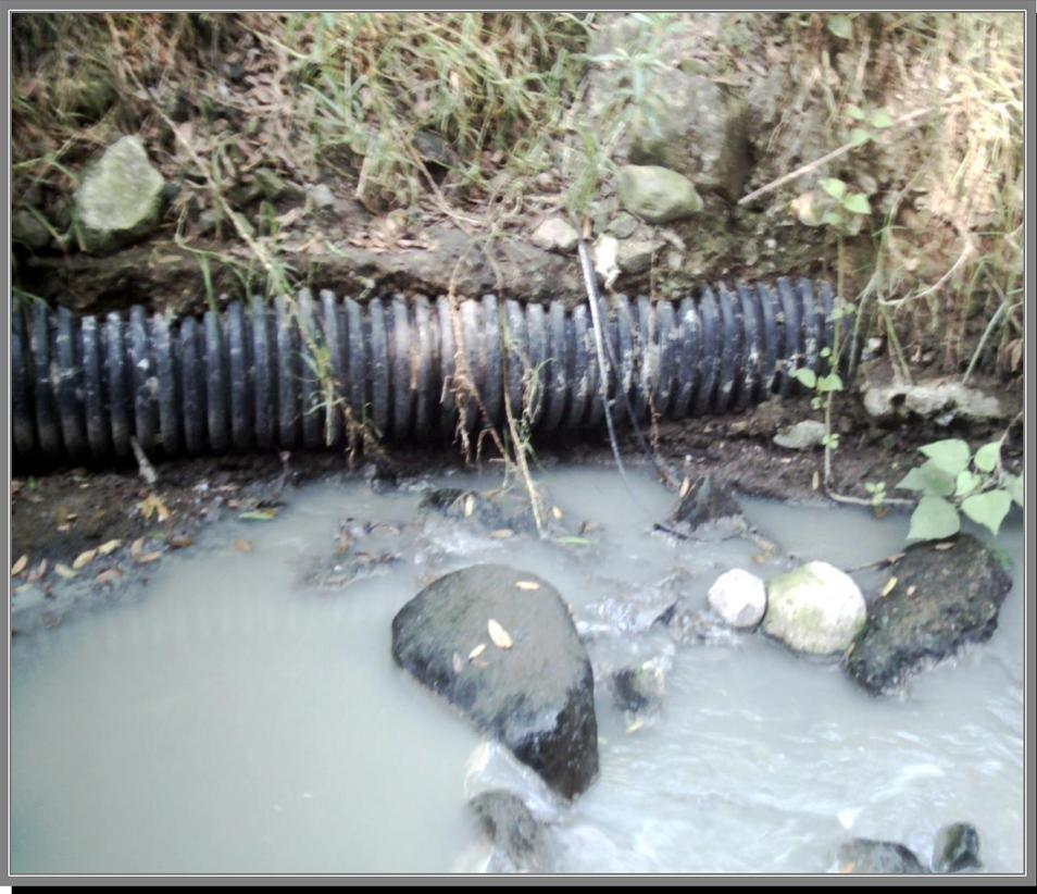
**Foto 30. Colector Marginal superficie del terreno y con daños**
